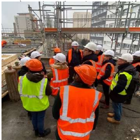
Visite chantier "Les Toits de Belleville".
