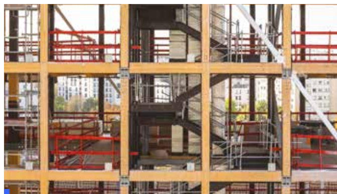
projet façade Denfert - bâtiment structure bois, bardage bois brûlé. Niveau 3 label biosourcé MO Cogedim, Moe Tham & Videgård + CALQ, BE environnement Zefco.
