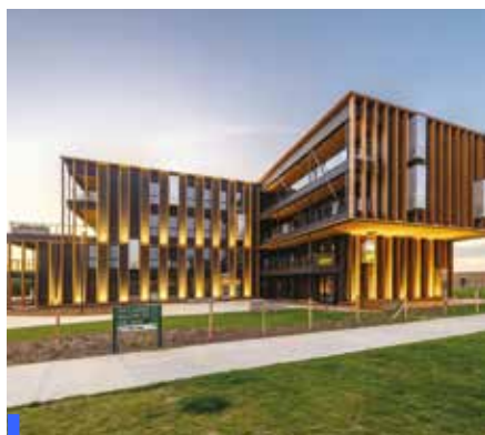
Le bâtiment Woodtime One - Parc d'activités de l'Aérodrome à Bondues – Crédit : LDKphoto
