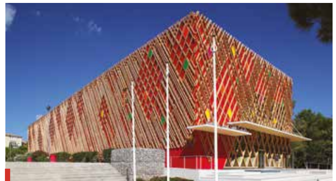
Ywood Odysseum à Montpellier (34). Construction en structure bois du siège social régional de Nexity en R+3 avec terrasse au dernier étage. Lauréat du Prix Pyramide d'Argent 2017, catégorie bâtiment bas-carbone.
