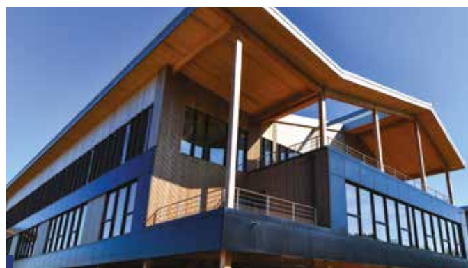
VILLENEUVE D'ASCQ (59) - Site de la Haute Borne - Grand Carré - Campus AUCHAN. Construction d'un immeuble de bureaux en R+3 de 2030 m 2 de surfaces de plancher
