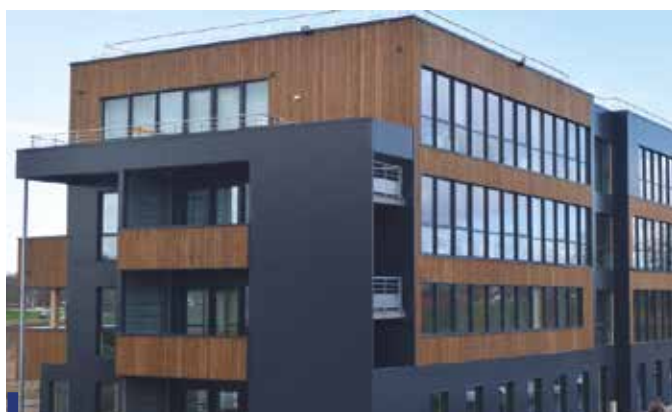
SCHILTIGHEIM (67) - «WOODEN PARK 2». Construction d'un ensemble immobilier de 15000 m 2 de SP en 5 bâtiments de type R+2
