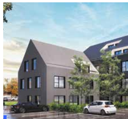
Reims (ZAC de Bézannes) construction d'un bâtiment de bureau.
