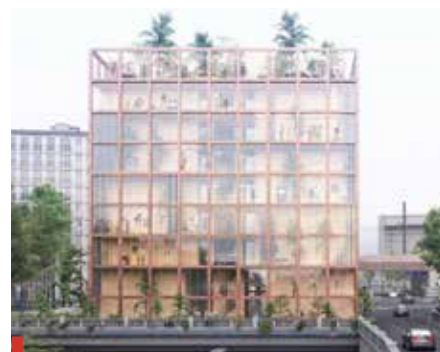
Réalisation d'une résidence jeunes travailleurs NF Habitat HQE et BBCA à Paris (75) pour Woodeum. Harel Le Bilhan Architectes. Crédit photo : Harel Le Bilhan Architectes
