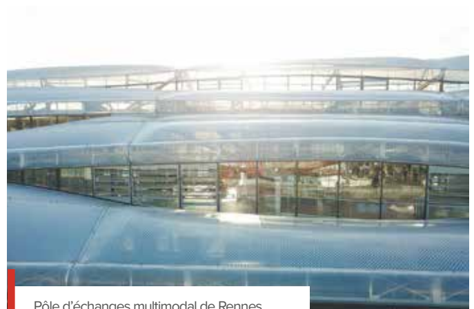
Pôle d'échanges multimodal de Rennes, Vue drone de la toiture, détail (Janv. 2019).
