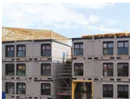
Coallia à Montreuil (93). Réalisation d'une résidence sociale en construction modulaire de 250 places sur la commune de Montreuil (93) pour Coallia Habitat Moon Architecture. Crédit photo : Potion médiatique
