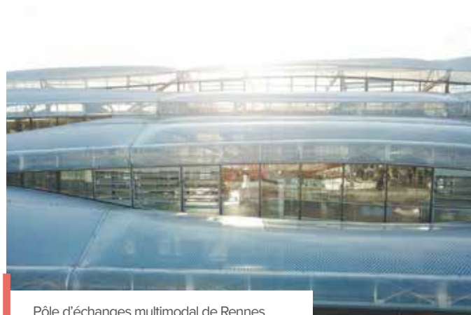
Pôle d'échanges multimodal de Rennes, Vue drone de la toiture, détail (Janv. 2019).
