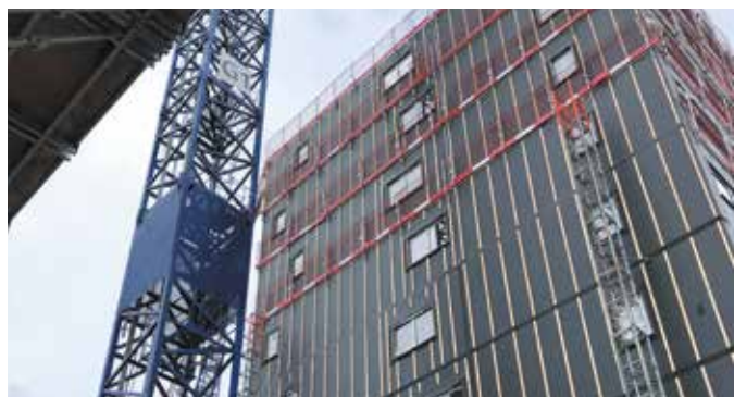
Chantier TREED IT, en cours de construction: immeuble R+11 (structure bois mixte) à la Cité Descartes comprenant bureaux, résidence étudiants, commerces et services – parking 3 niveaux ossature bois et dalle active mixte bois-béton.
