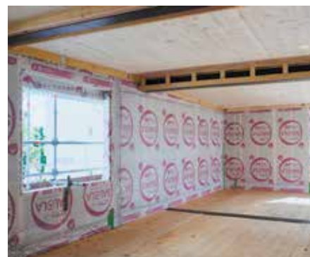
Rénovation bas carbone d'une tour par remplacement des façades, en site occupé, par des panneaux préfabriqués en bois. Sarcelles (95).
