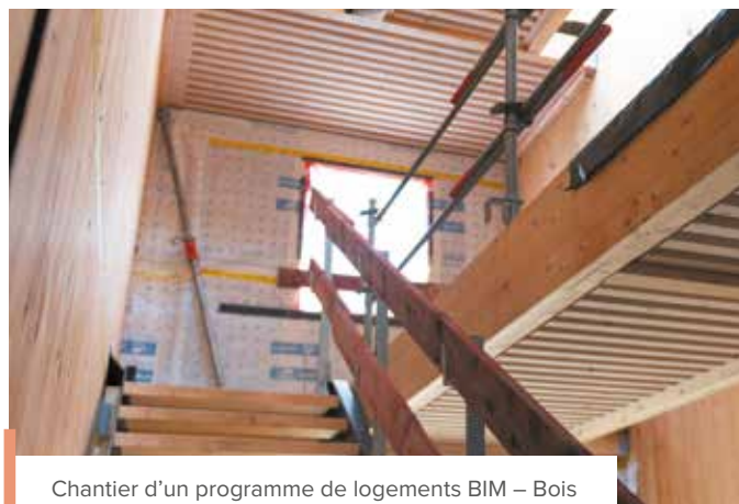
Chantier TREED IT, en cours de construction: immeuble R+11 (structure bois mixte) à la Cité Descartes comprenant bureaux, résidence étudiants, commerces et services – parking 3 niveaux ossature bois et dalle active mixte bois-béton.
