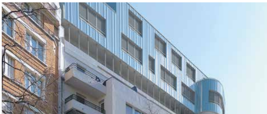
Réhabilitation Plan Climat énergie en site occupé de 37 logements collectifs et création de 12 logements par surélévation en structure bois. Paris (75012). Habitat Social Français.
