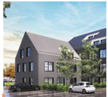
Reims (ZAC de Bézannes) construction d'un bâtiment de bureau.
