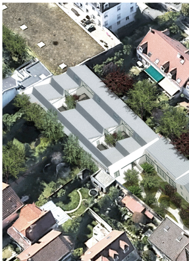
Transformation-rénovation performante d'une hall industrielle en 7 logements à Saint-Maur (94)
