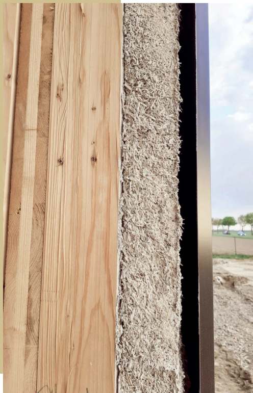
Crédit photo : Wall Up' Préfa
